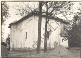
1. Vedere dinspre nord vest Clopotnița adăugată
