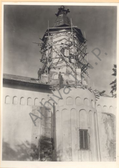
1. Latura sud unde s-a descoperit baza pătrată a turlei panteocratorului. La contrafort se văd alterările cărămizilor și a pietrelor. Fereastra absidei lărgită. (vedere din timpul restaurării)
