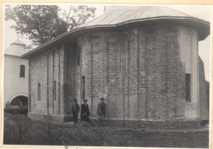
1. Vederea laturii sud după restaurare
