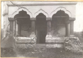
L. Vederea pridvorului deschi
