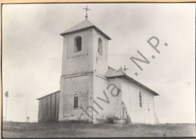
1. Vedere dinapre sud-vest
