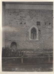
1. latura sud după descoperirea urmelor vechiiului pridvor deschis, azi darănat
