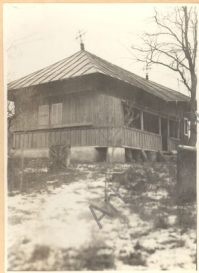
1. Vedere din spre sud-vest
